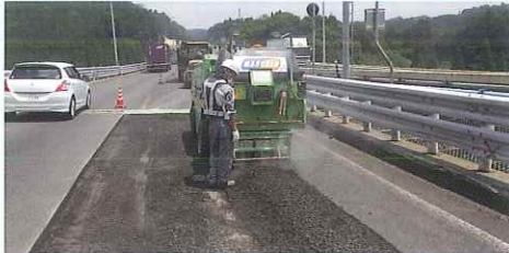
〔橋梁補修工事〕
